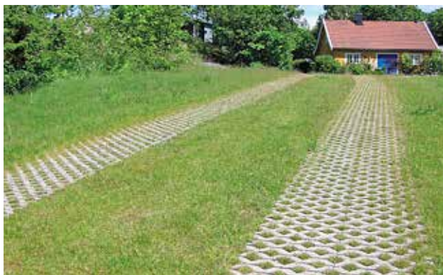
Så här kan armering av gräsmatta se ut för att klara av fordon.
