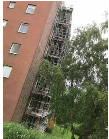
Allt är på plats för fortsatt fönsterbyte – utom klara besked från Stadsbyggnadskontoret.
